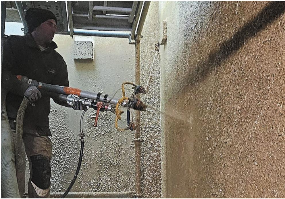
La machine projette en même temps de la terre et du chanvre, à haute pression, pour coller l'ensemble sur le mur.
